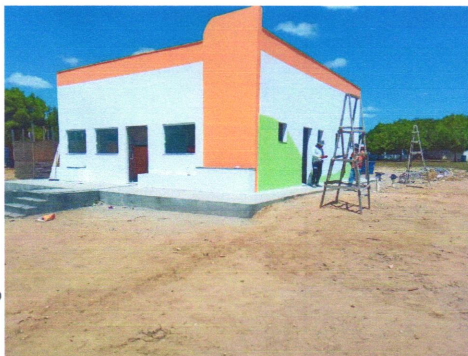
FOTO 10 – APLICAÇÃO MANUAL DE PINTURA COM TINTA LÁTEX ACRÍLICA EM PAREDES, DUAS DEMÃOS. AF_06/2014
