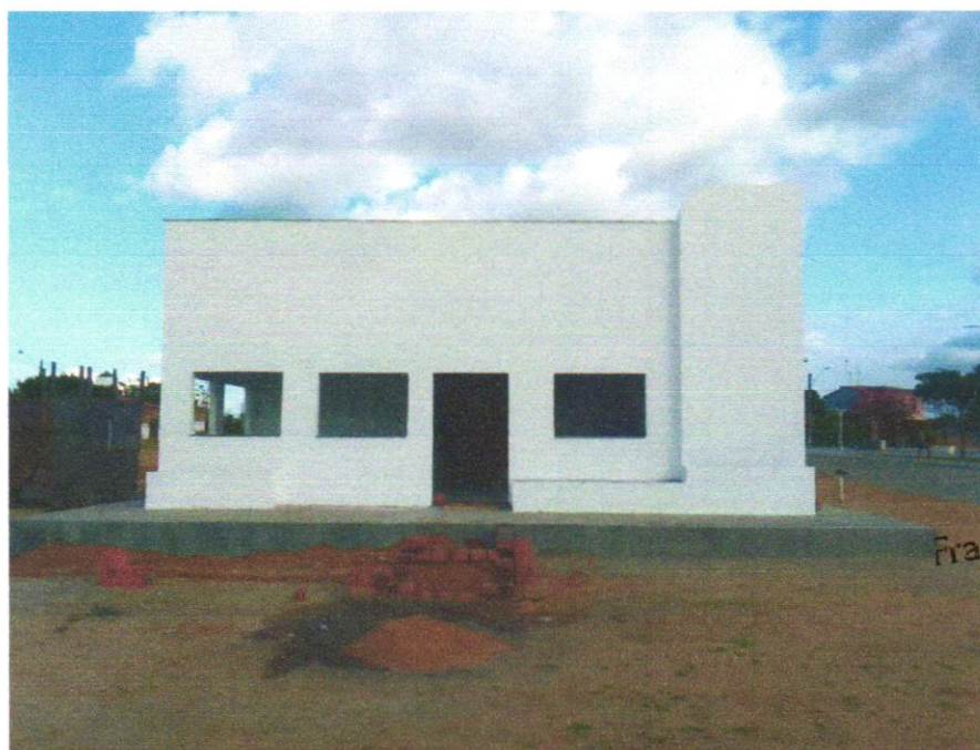
FOTO 9 - APLICAÇÃO E LIXAMENTO DE MASSA LÁTEX EM PAREDES, UMA DEMÃO. AF_06/2014
